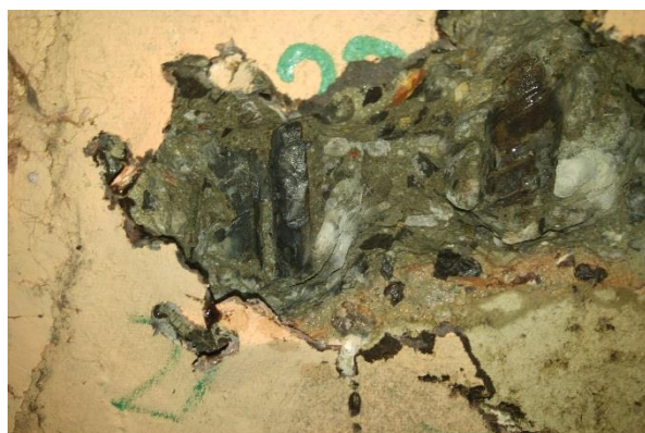
Pruty betonářské výztuže ØV12 a Ø V24 (25?).
