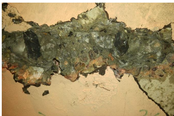
Pruty betonářské výztuže ØV24 (V25?).
