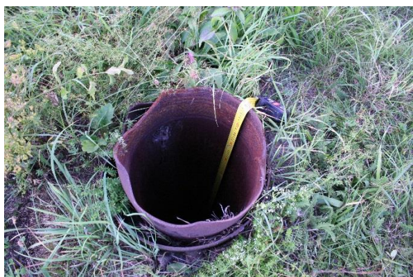
V zeleném pásu v linii výstupu č. 3 je situován pažený vrt.
