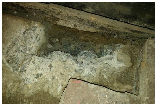
Sonda č. 3 – S narůstající hloubkou sondy nabývaly projevy zavlhnutí na intenzitě.
