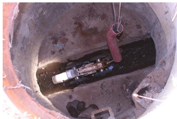
Robot s kamerou v kanalizační šachtě, betonové potrubí \varnothing 300 mm odvádí přečerpanou vodu z jímky do hlavního řadu.
