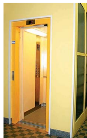
Gen2 NOva – modernizace výtahu
