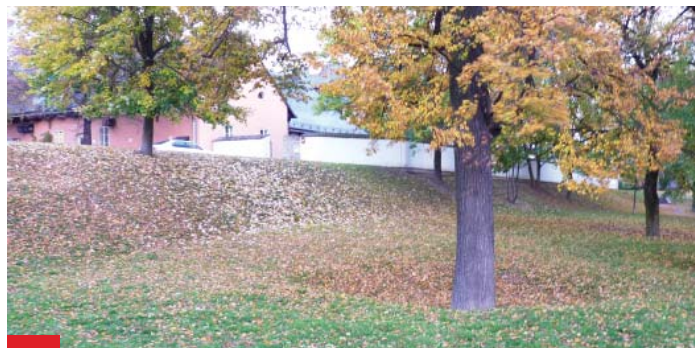
Hráz bývalého rybníku pod zámekem v Zábřehu
