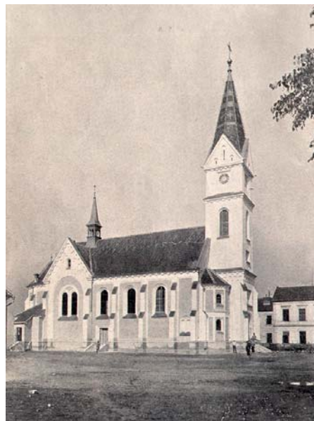
Kostel po dokončení v roce 1910.
