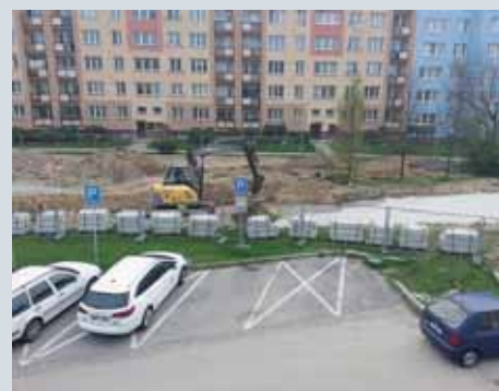
PRÁVĚ PROBÍHAJÍCÍ výstavba dopravního propojení ulice V. Jiříkovského-Kaminského na Dubině.
