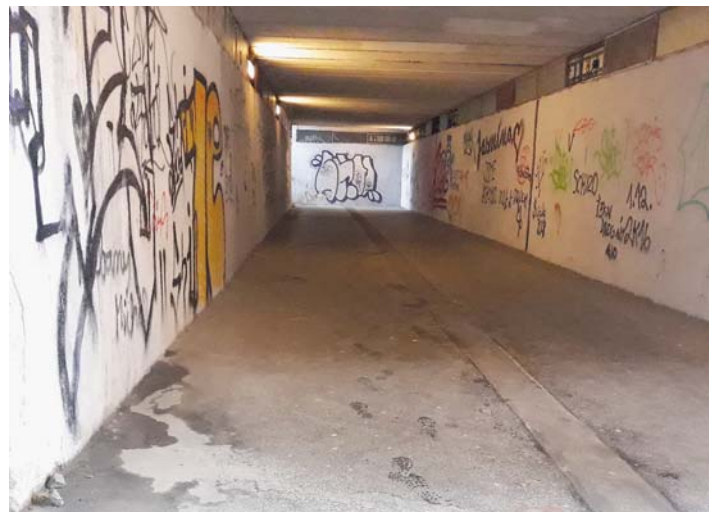
PODCHOD je ve špatném stavu. Při dešti do něj zatéká a lidé se musí vyhýbat kalužím.
