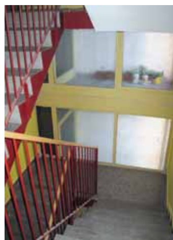
NOUZOVÁ EVAKUAČNÍ stěna, otvorem vpravo nahoře se lze po vyklonění dostat do prostorů schodiště.
