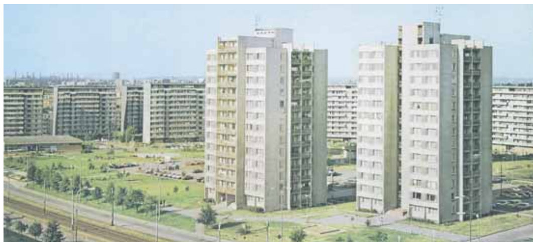
VĚŽOVÉ DOMY T06B–BTS ve Výškovicích. Na snímku lze dobře spatřit rozdíly mezi předním a zadním průčelím.
