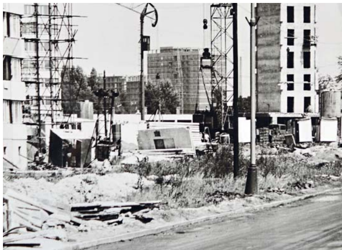
BETONOVÁNÍ úzkého a vysokého monolitického jádra. FOTO / ARCHIV AUTORA
