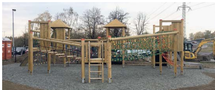
DŘEVĚNÉ HŘIŠTĚ na ulici Pavlovova je již přístupné dětem.
