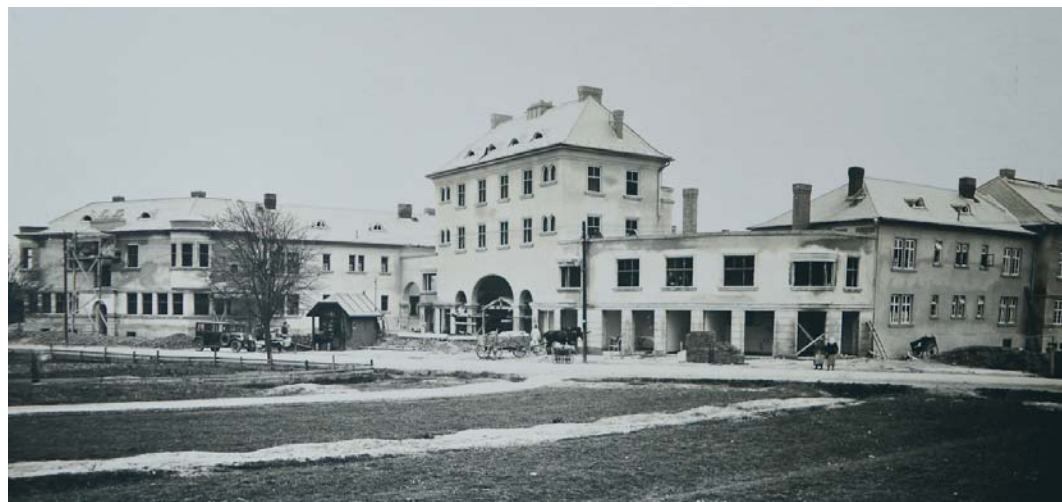
STAVBA DOMŮ u Závodní ulice, 1928.
