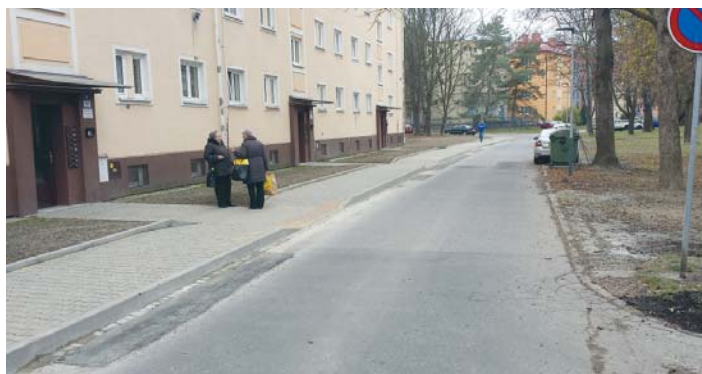
CHODNÍK na Gerasimovově ulici už slouží obyvatelům.
