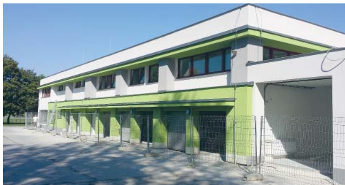
REKONSTRUKCE SÍDLA Technických služeb trvala dva roky. FOTO / ARCHIV TSOJ
