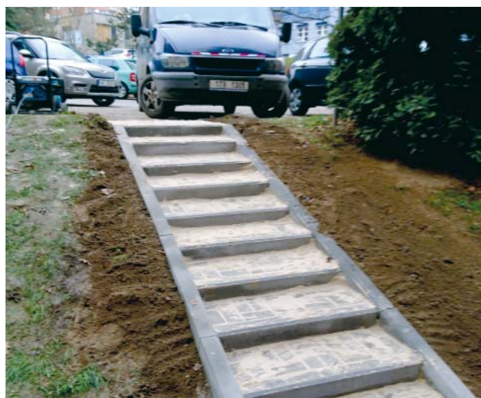
DALŠÍ PROJEKT, který bude brzy dokončen, jsou Schody pro postižené ve Výškovcích. V lednu bude dodáno zábradlí.
