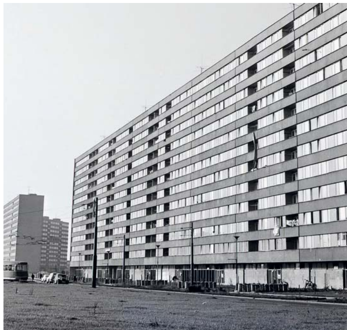
EFEKT PÁSOVÝCH OKEN přes celá průčelí již zanikl.
