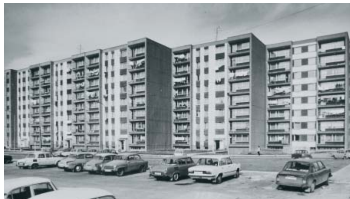
PANELOVÉ DOMY BP70-OS-R na Jugoslávské ulici, včetně typického svislého členění fasády.
