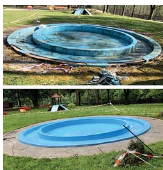
Bazén před rekonstrukcí a po ní.
