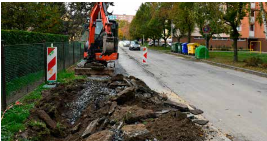
Oprava chodníku a vozovky na ulici Oráčova
