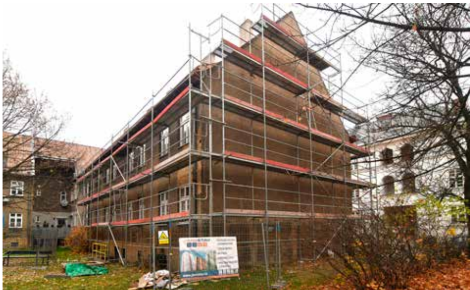
Právě probíhající rekonstrukce bytového domu na ulici Mládeže 12
