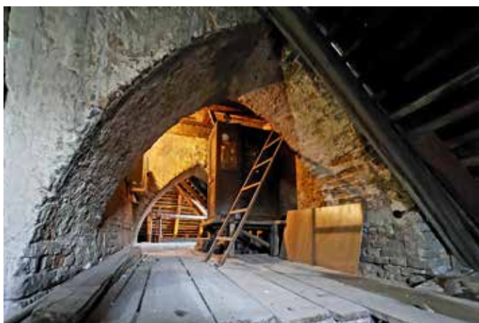
Zdivo věže kostela v Zábřehu
