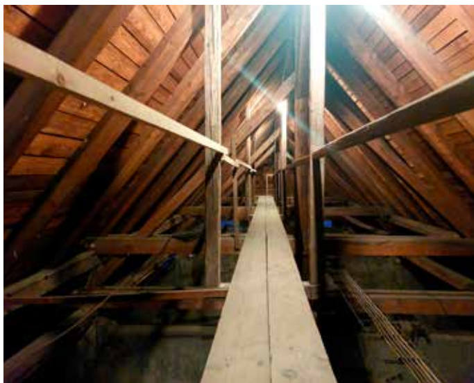
Pohled na podkroví kostela v Hrabůvce
