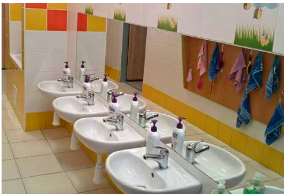
Rekonstrukce sociálního zařízení, MŠ Dvorského 4 / 4,152 mil. Kč
