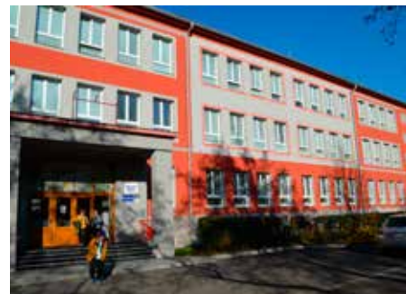
V Základní škole Provoznická budou opravena sociální zařízení včetně rozvodů.
