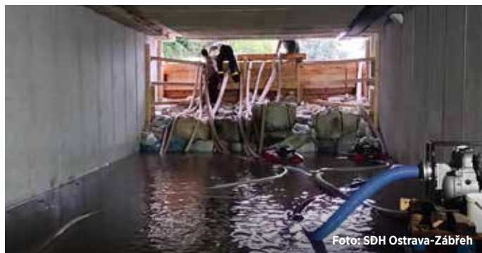
Stavba protipovodňové zábrany v podchodu
